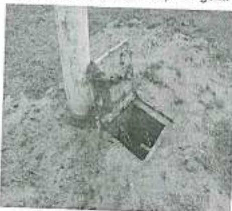
Instalação das caixas de passagem.
