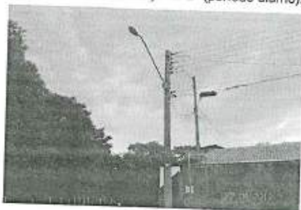
Após instalação do braço de IP (período diurno).
