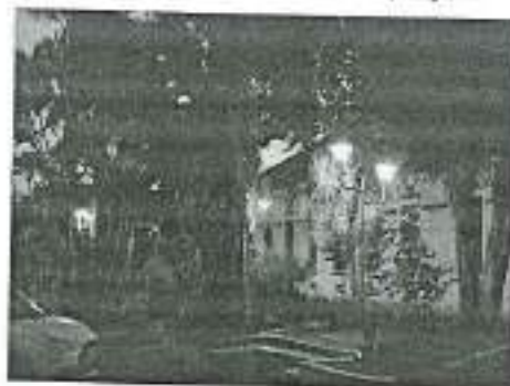
Após a readequação.
