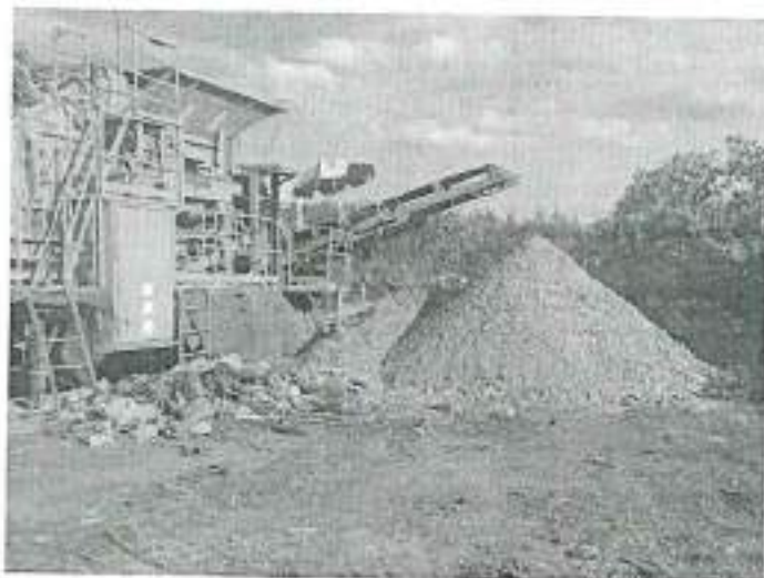
Projeto de britagem e reciclagem de RCC
