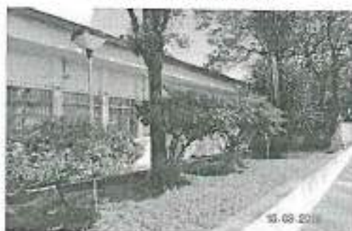
Antes da readequação.
