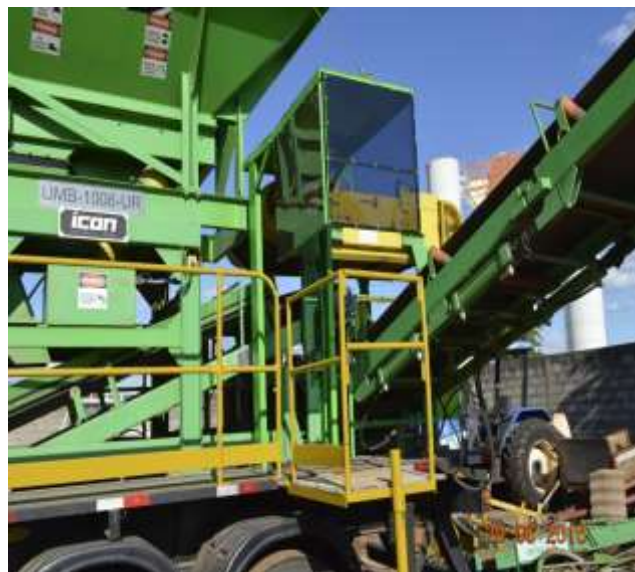
INCLUSÃO DE PLATAFORMA E INSTALAÇÃO DE PROTEÇÕES (INFERIOR)
