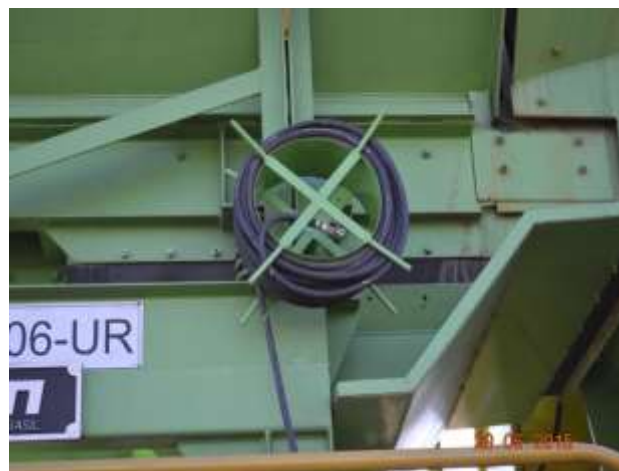
INCLUSÃO DE SUPORTE E SISTEMA PARA LAVAGEM DO EQUIPAMENTO MÓVEL DE BRITAGEM
